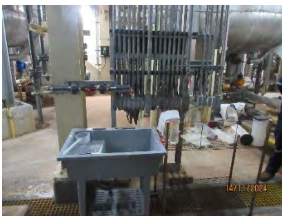
ภาพที่ 2.2-55 ถาดรองรับการระบายของเหลว
