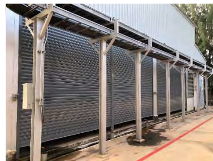
ภาพที่ 2.2-56 อาคารควบคุมเสียงจากเครื่องจักร
