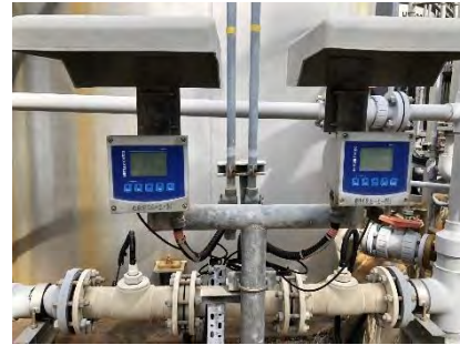
ภาพที่ 2.2-15 อุปกรณ์ ORP Sensor
