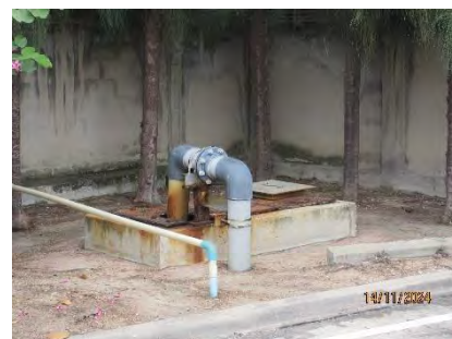
ภาพที่ 2.2-8 ถังรวบรวมน้ำเสีย (Waste Water Inspection Pit (V89-N))
