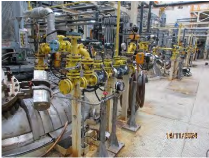
ภาพที่ 2.2-41 อุปกรณ์ตรวจสอบและป้องกันการรั่วไหลของก๊าซคลอรีน
