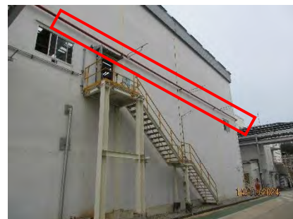
ภาพที่ 2.2-6 ระบบม่านน้ำปิดคลุมอาคารถังปฏิกริยา
