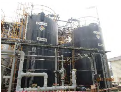
ภาพที่ 2.2-11 HCL Storage Tank
